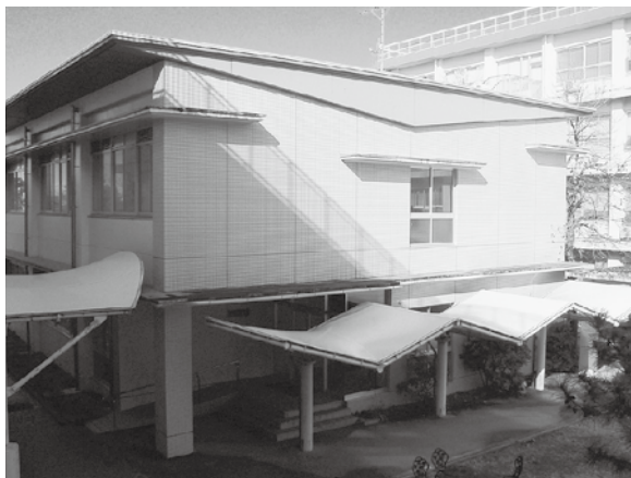
生物生産工学棟(平成8年新設)
