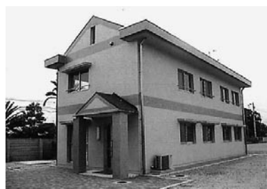
平成8年3月竣工 黒潮会館
